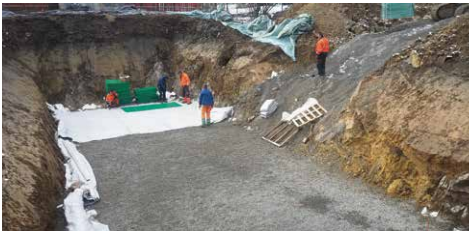
Rekonstrukcija Roške ceste, marec 2019 • Foto: arhiv Občine Kočevje
